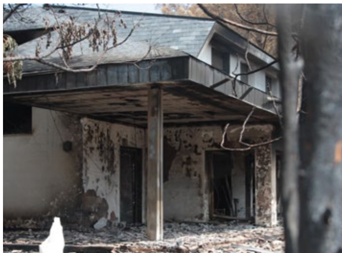
Imatge 6. Un dels habitatges destruïts al incendi forestal de Llutxent de 2018. Font: Dalmau-Rovira, F.
